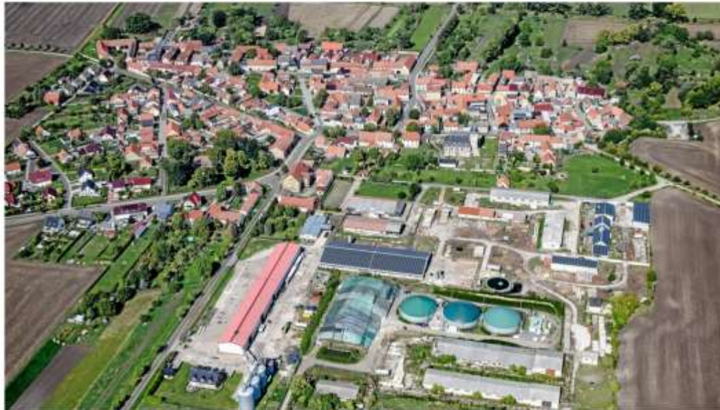
Am Ortsrand von Kleinneuhausen steht eine Biogasanlage, auch Photovoltaikanlagen gibt es bereits.
